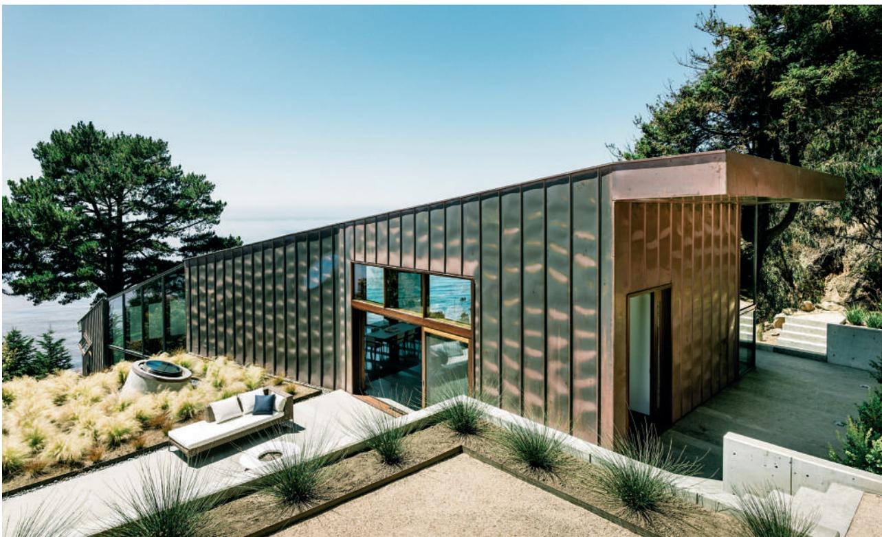
建築西南面外牆以銅片包覆以抵抗西北邊吹來的強風，另一側則採用玻璃來展開視野。
